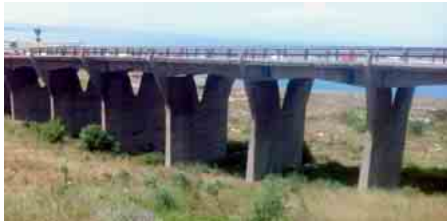
IL VIADOTTO DI CONTRADA TARGIA
